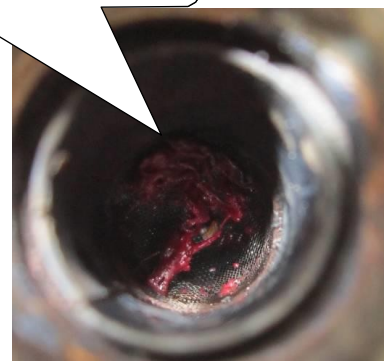
Le filtre est bloqué par des impuretés, l'aspiration du compresseur sera anormale
