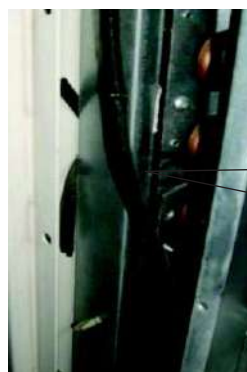
Après le nouveau raccordement, le système revient à la normale
