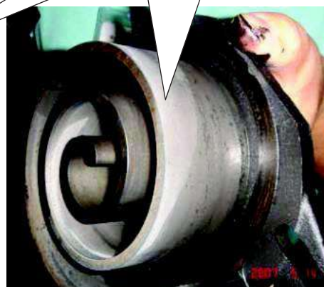
Le roulement est très abîmé, il est complètement endommagé.
