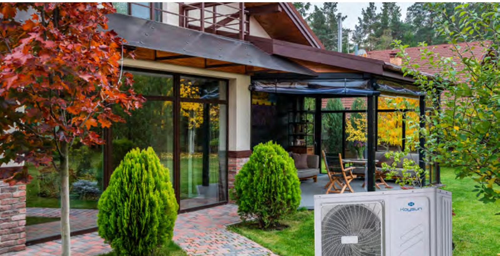
KHPS-MO PRO HP è la soluzione più compatta della gamma poiché è composta soltanto da un'unità esterna, un comando a filo e un deposito di ACS (opzionale). Questa è soluzione più adeguata per gli impianti dove non ci sono più di 5-6 metri tra l'unità esterna e il serbatoio di ACS. KHPS-MO PRO HP è controllabile dall'applicazione mobile di Kaysun.
