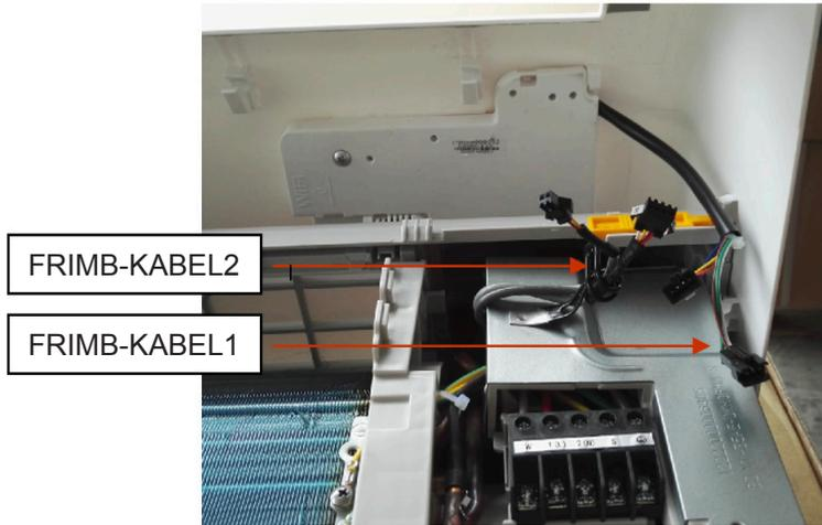
Schritt 5: Installieren Sie die Support- und Multifunktionsbox.
